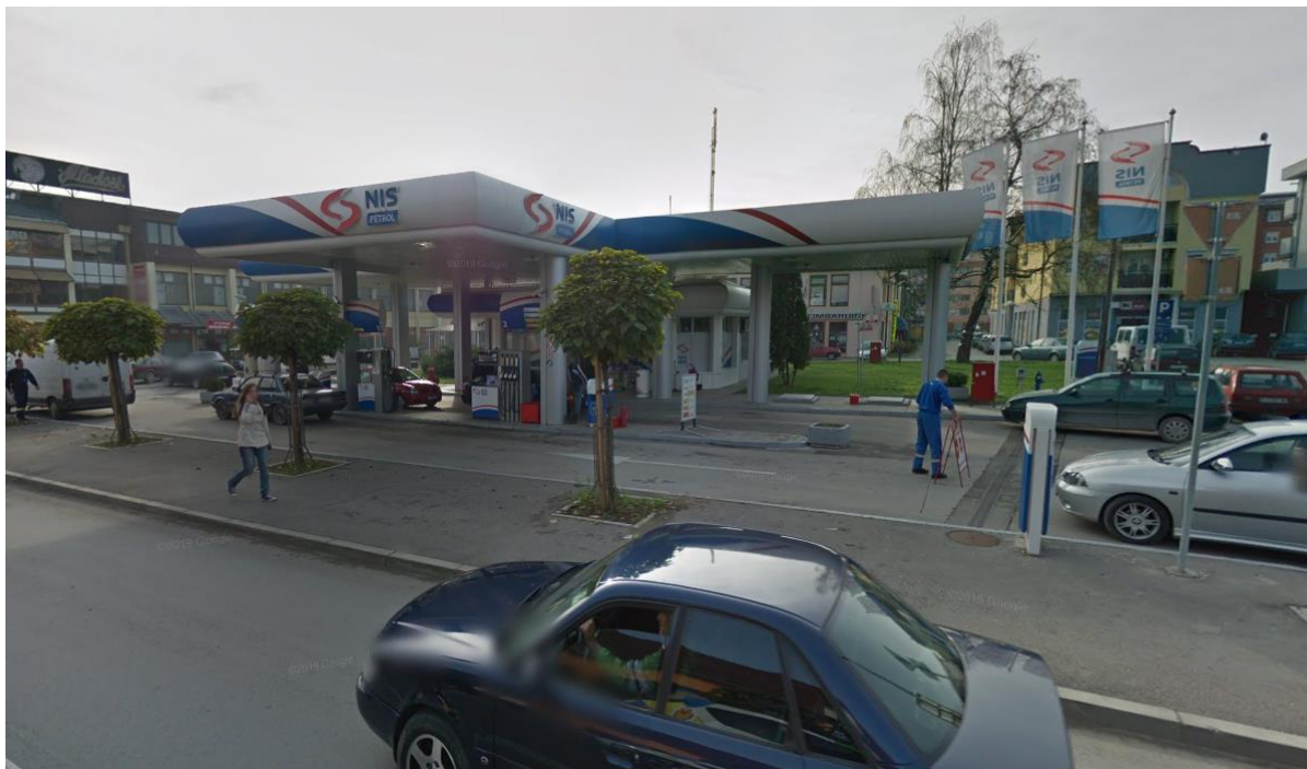
Слика 3. Постојећи комплекс НИС пумпне станице Пожега
