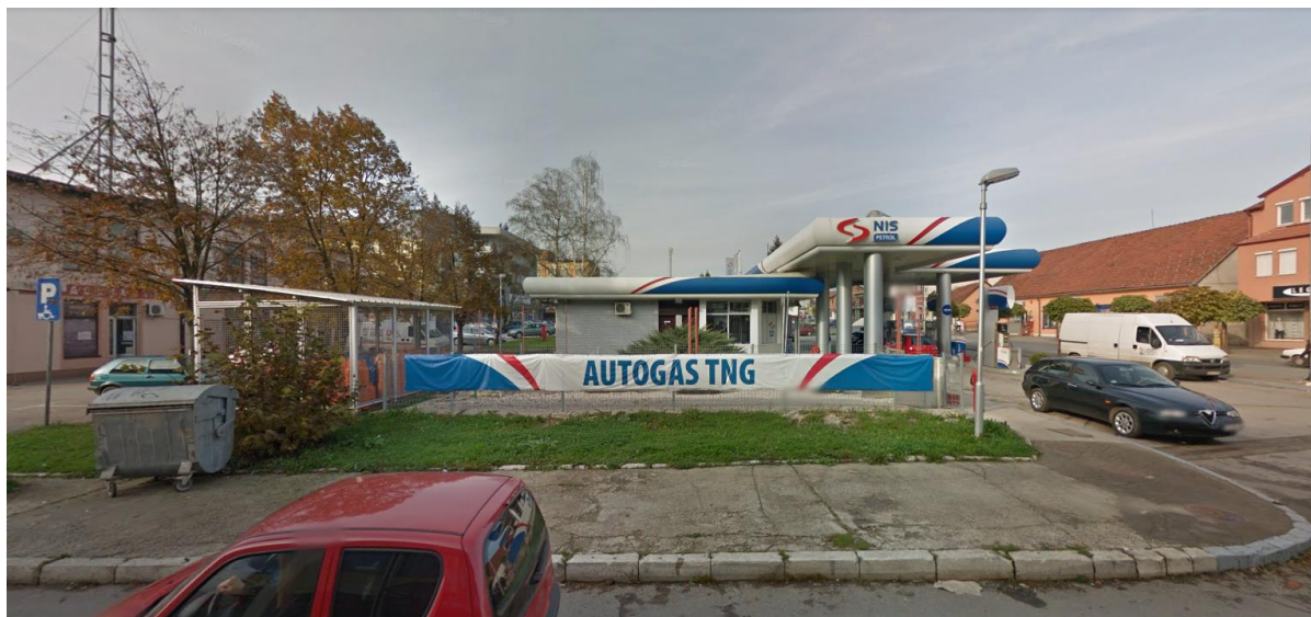
Слика 1. Постојећи комплекс НИС пумпне станице Пожега
