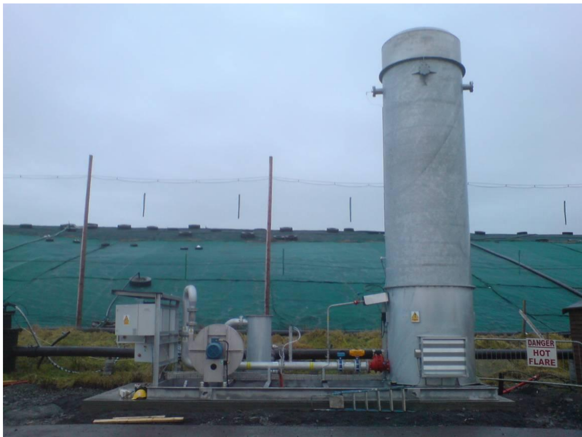
Слика 7.30. Пример постројења за спаљивање депонијског гаса са бакљом затвореног типа
